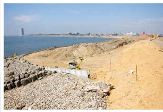
Deichbauarbeiten in Büsum
