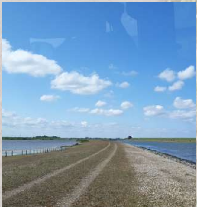
Blick auf den Speicherbeckenwall
